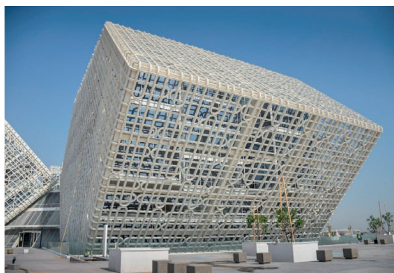
Fig. 8: Involucro di un edificio nel Qatar (foto: Ayman Badr)
