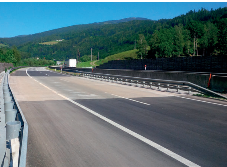
Fig. 9: Rinforzo di un ponte (foto: TU Graz)
