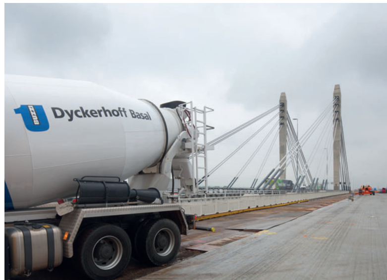
Fig. 10: Ponte Ewijk (foto: Bart van Hoeck)
